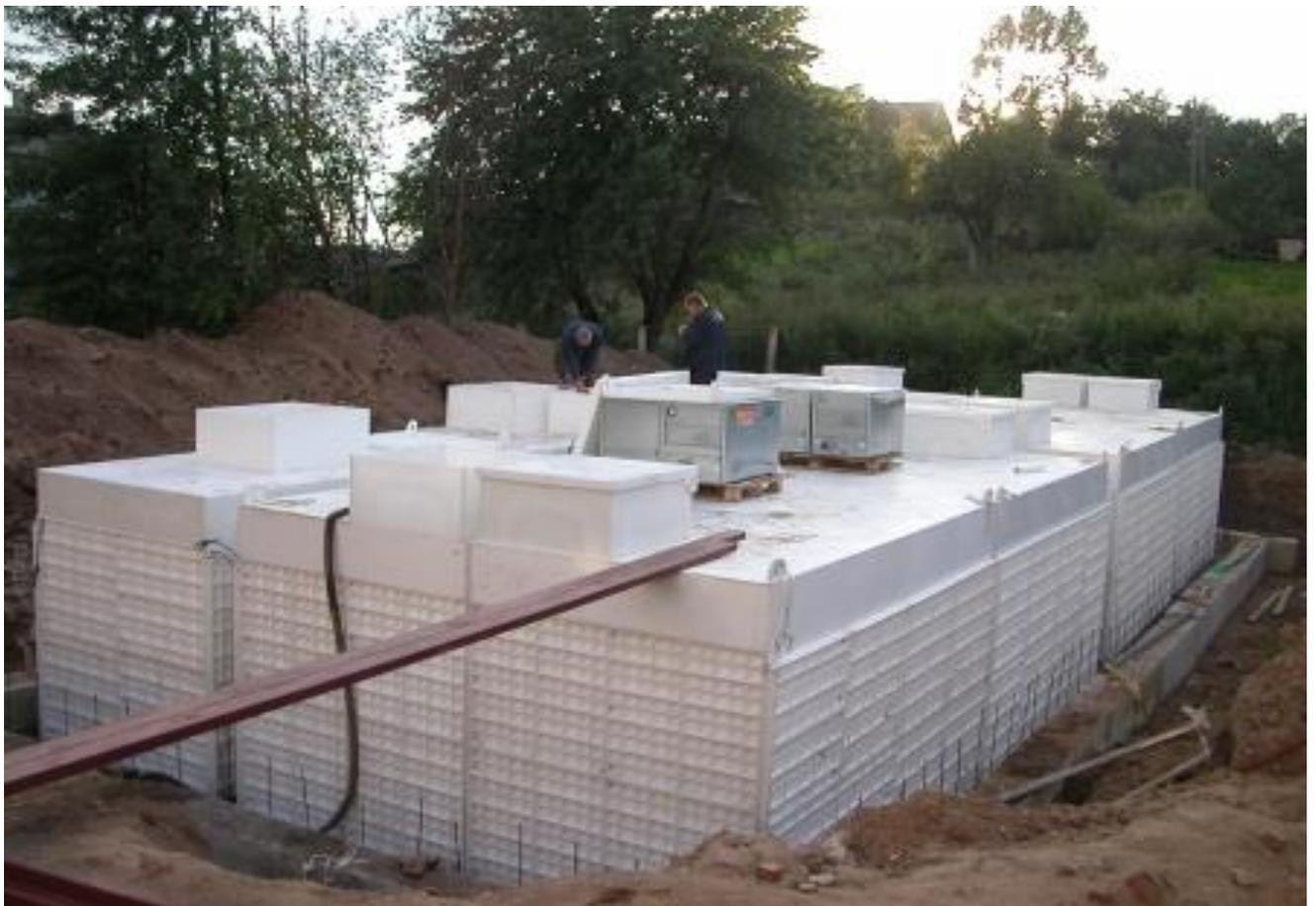
**Рис.12.2. Блочные канализационные очистные станции**
