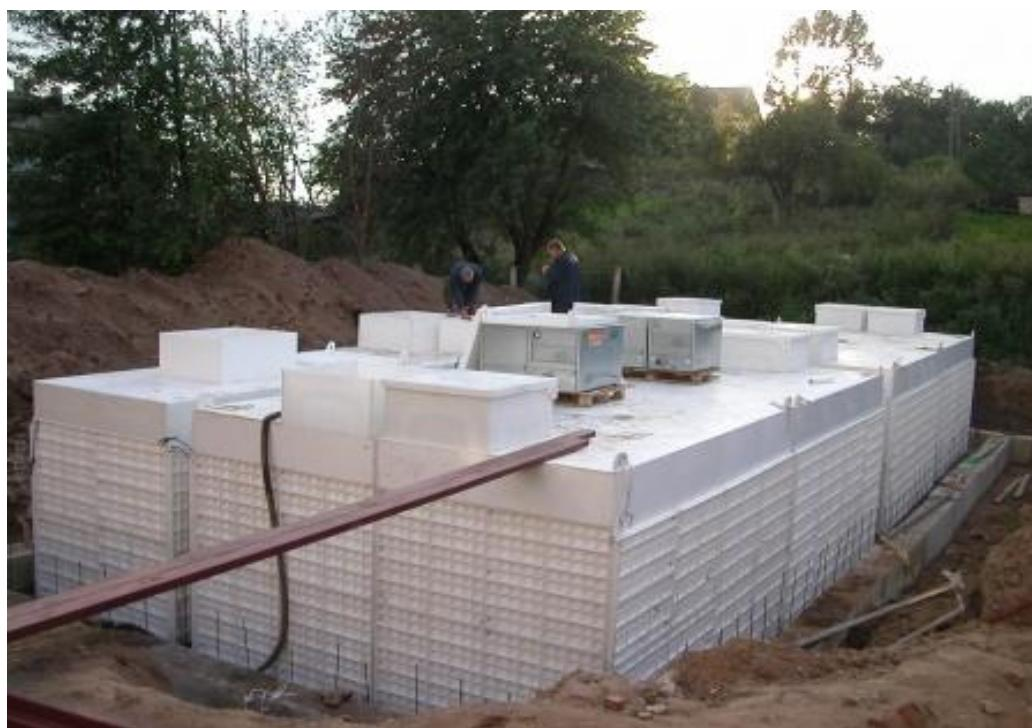
**Рис.12.2. Блочные канализационные очистные станции**
