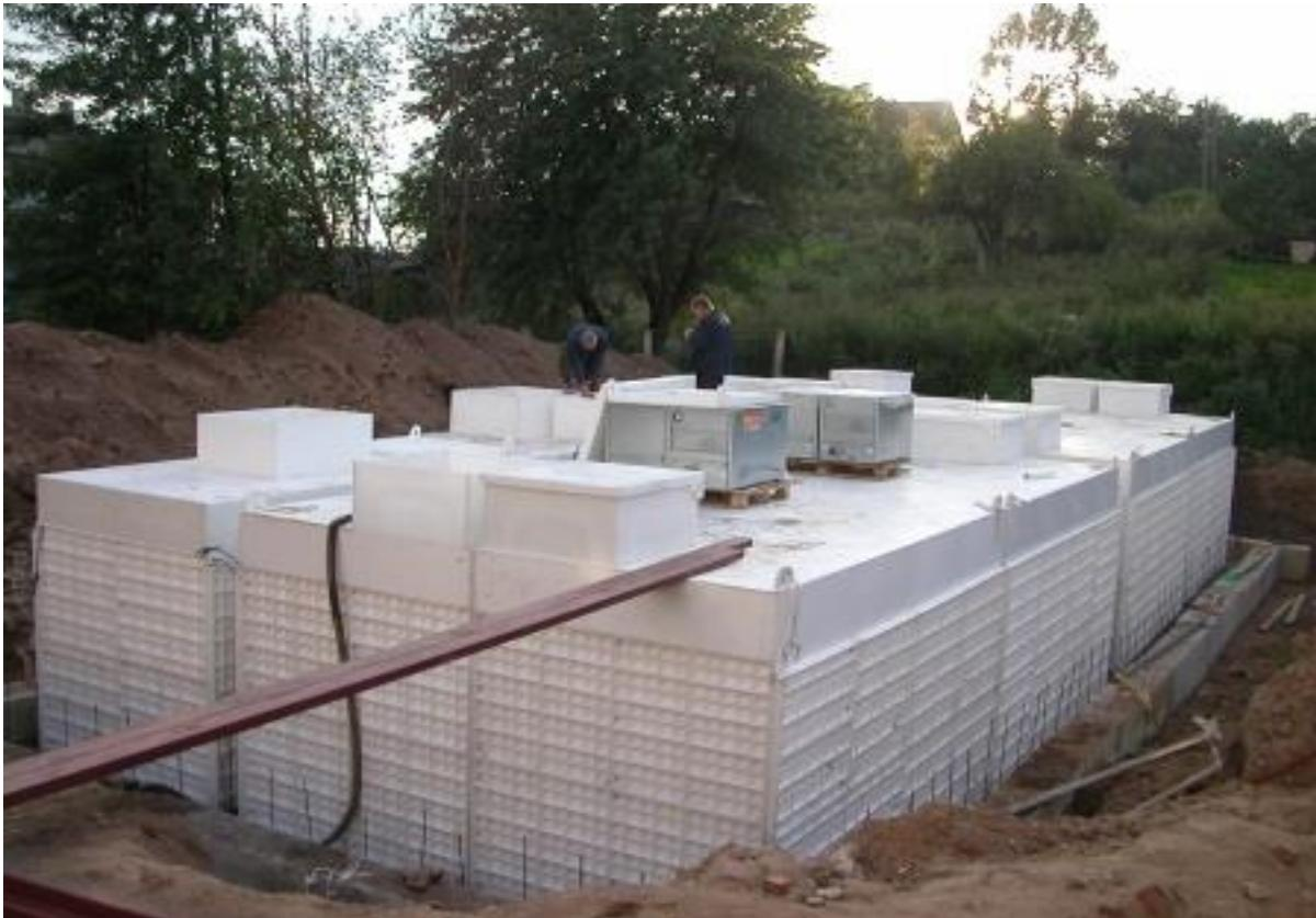
**Рис.12.2. Блочные канализационные очистные станции**
