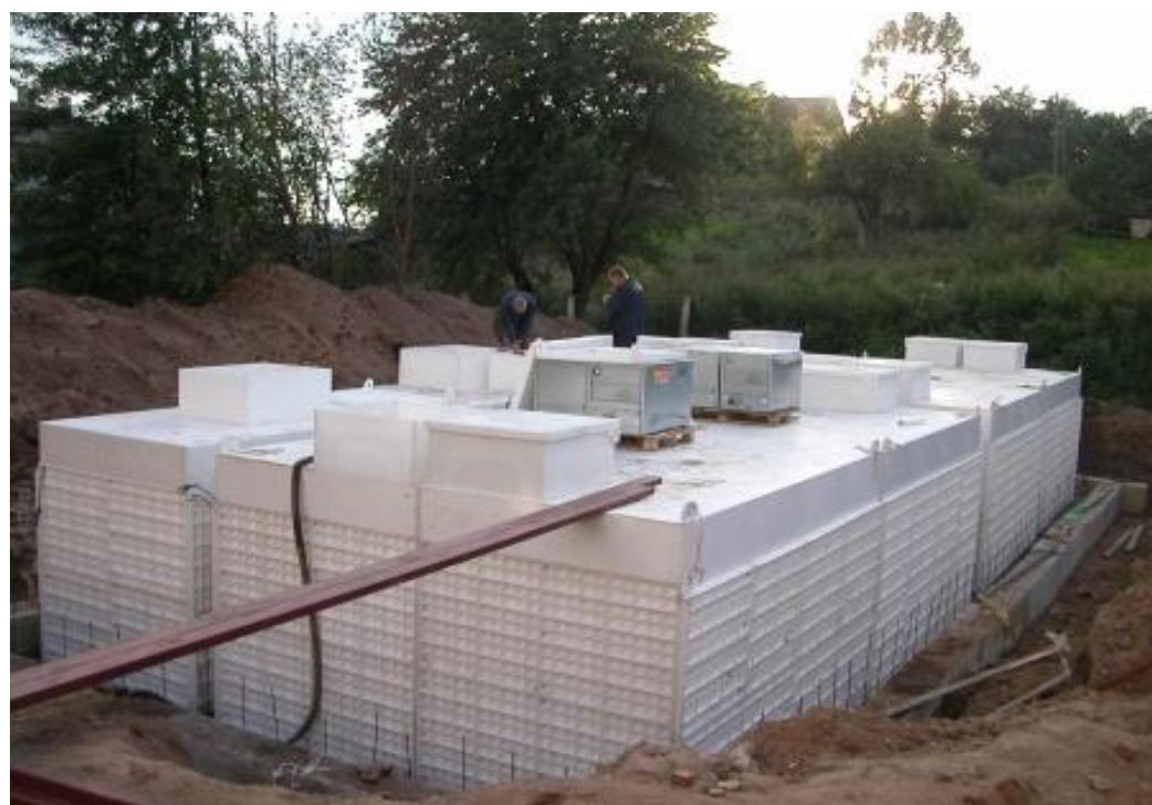
**Рис.12.2. Блочные канализационные очистные станции**
