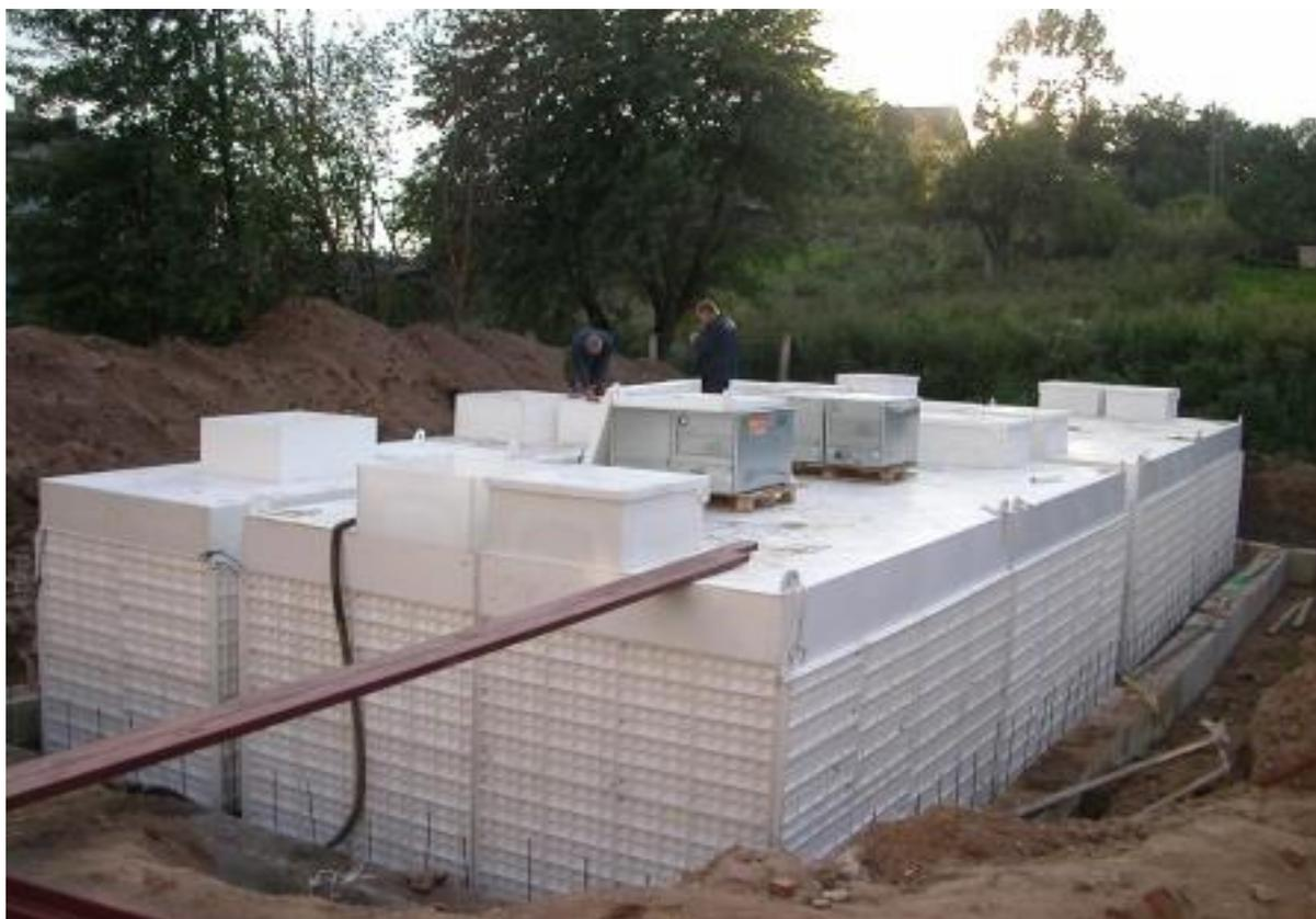
**Рис.12.2. Блочные канализационные очистные станции**
