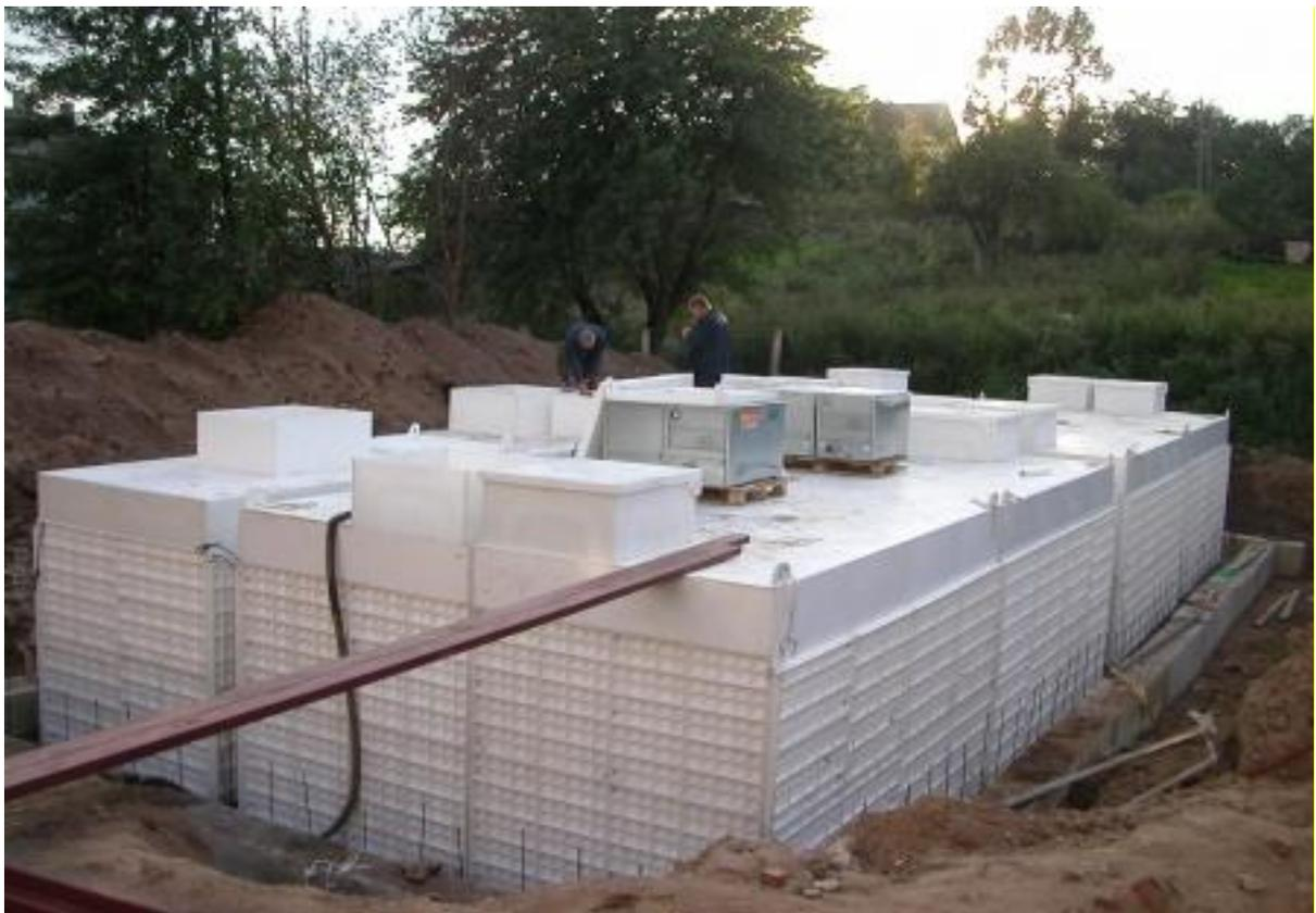
**Рис.12.2. Блочные канализационные очистные станции**
